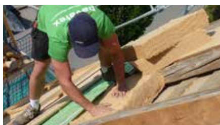
Abb. 2 Dachsanierung von außen ohne Beeinträchtigung des Innenraums.
