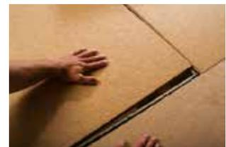
Abb. 8 Verkleben Anschlüsse und Bahnen
